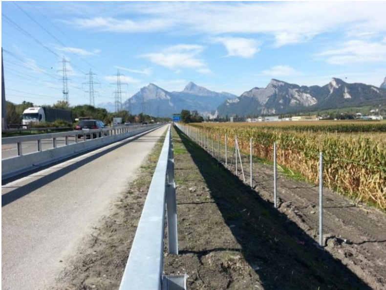
Abb. 20 FZRS System und Wildschutzzaun Bau 2014 (im Zusammenhang mit Kabelblock)
