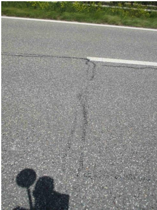
Abb. 5 Beispielbild Quer- und Längsrisse (km 127.00)
