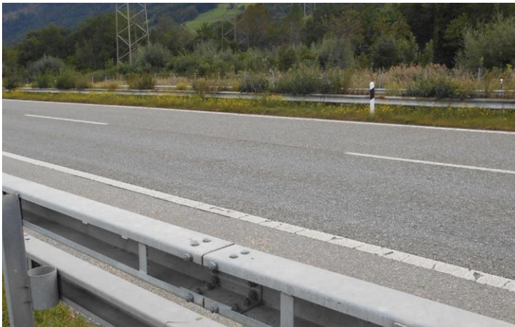
Abb. 7 Beispiel Ausmagerung / Spurrillen (km 129.4)
