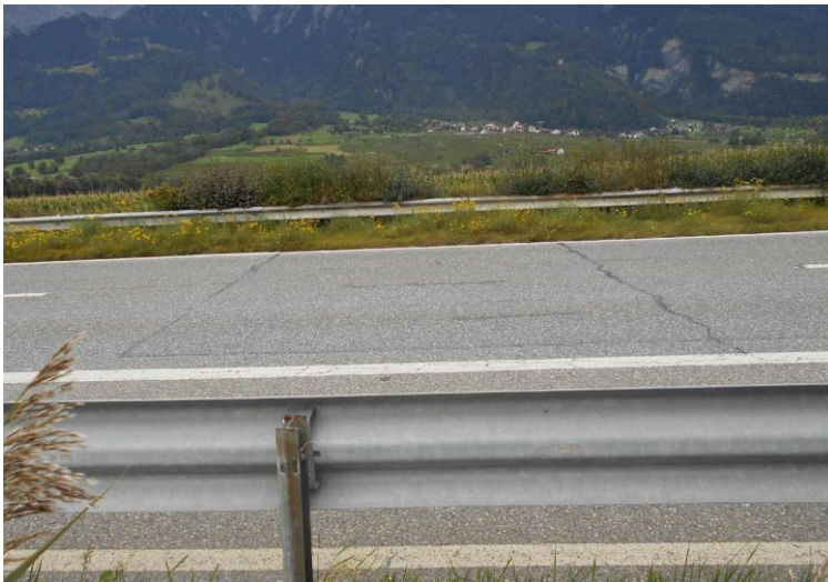
Abb. 15 Beispielbild Längs- und Querrisse (km 128.50)
